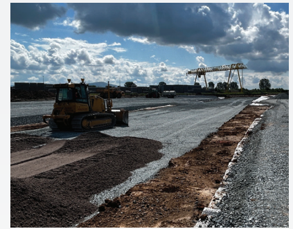
Tensar® InterAx® Geogitter zur Erhöhung der Tragfähigkeit
