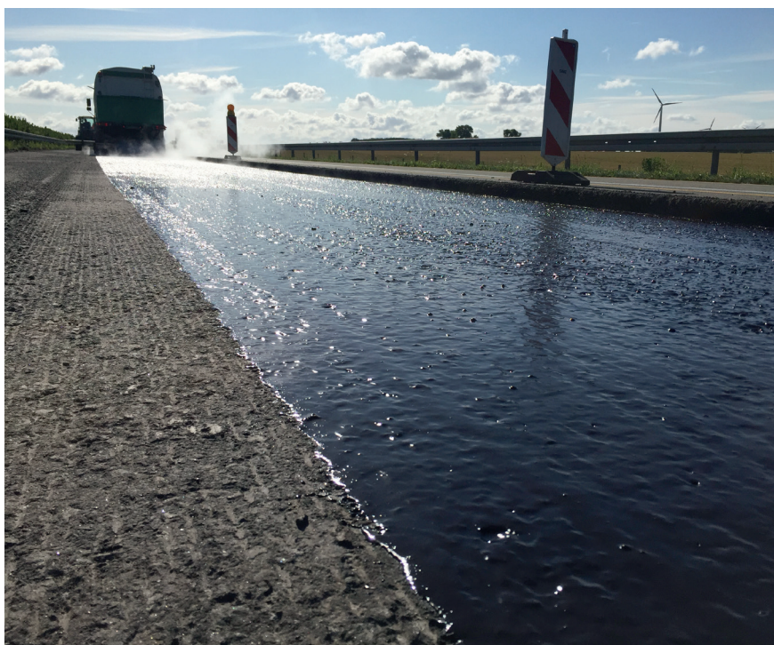
Anspritzen der polymermodifizierten Bitumenemulsion C70BP3-0B-1 (Quelle: Tensar International GmbH)
