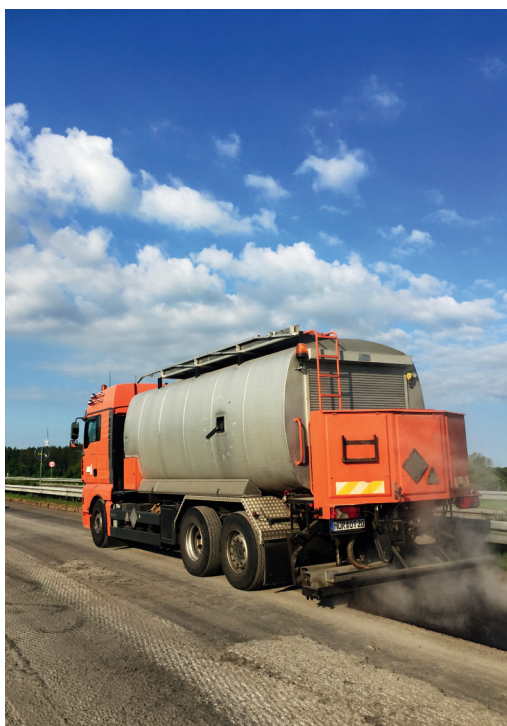
Anspritzen der polymermodifizierten Bitumenemulsion C70BP3-0B-1 (Quelle: Tensar International GmbH)
