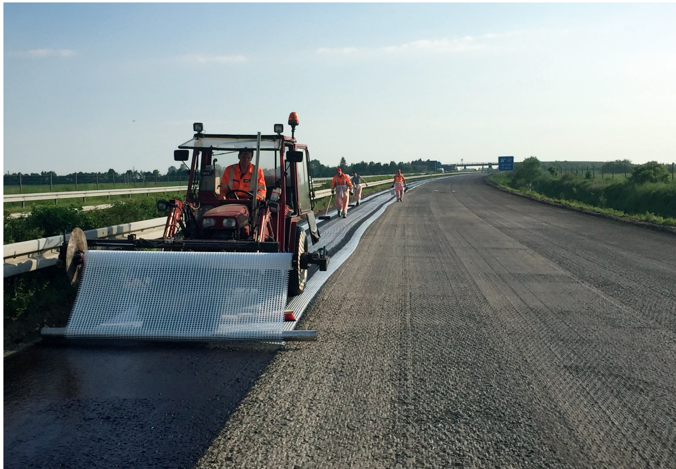
Bereich Strasburg, Verlegung von Tensar Glasstex Grid (Quelle: MOT Müritzer Oberflächentechnik GmbH)
