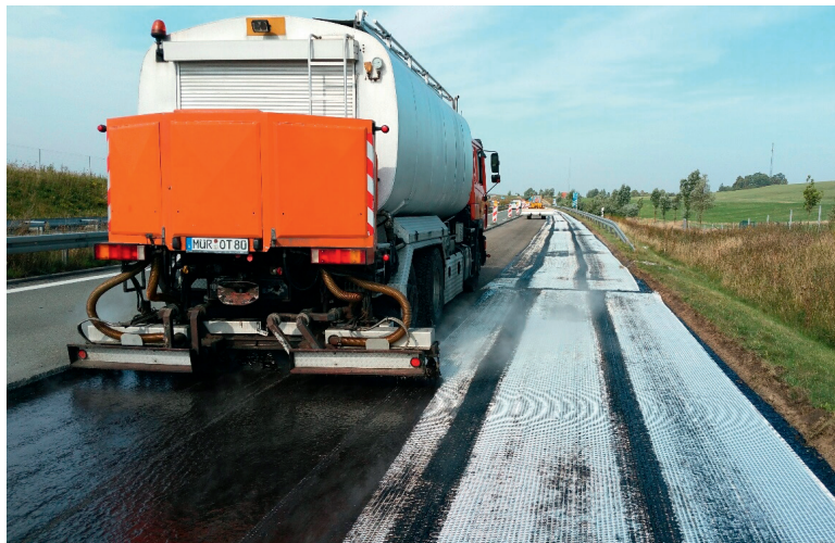
A20 Bereich Strاسبurg, Anspritzen der polymermodifizierten Bitumenemulsion C70BP3-0B-1 (Quelle: MOT Müritzer Oberflächentechnik GmbH)
