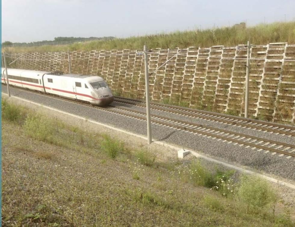
*TensarTech<sub>®</sub> NEW als Lärmschutzwand entlang einer Eisenbahnstrecke*
