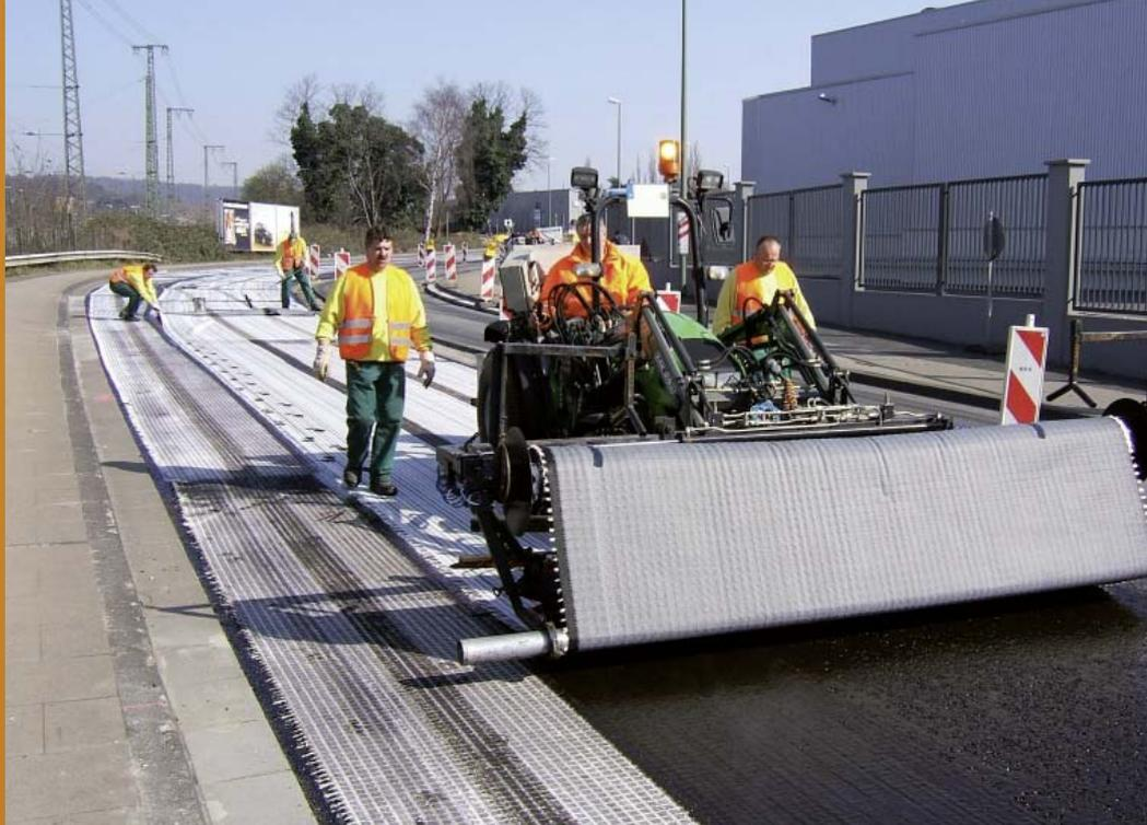
Sanierung einer innerörtlichen Straße mit Tensor<sub>®</sub> Glasstex
