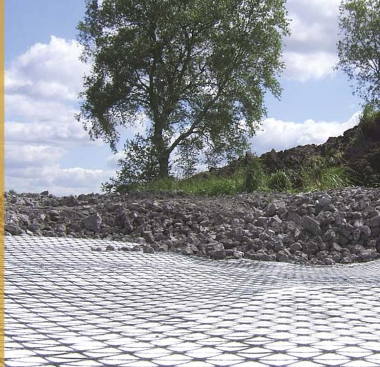
In Verbindung mit geeignetem Schüttmaterial bildet TriAx eine mechanische Stabilisierung mit außergewöhnlichen Leistungsmerkmalen
