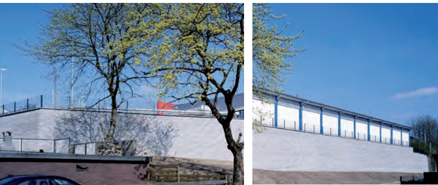
Bild 1: Die Ansicht der geogitterbewehrten Stützkonstruktion nach der Bauphase
