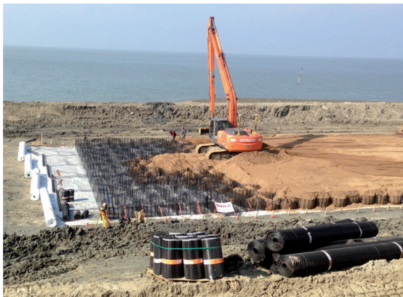
Bild 12: Einbau des Geozellensystems [15]
