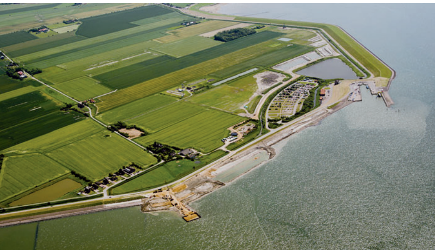
Bild 1: Luftaufnahme des Landesschutzdeichs „Alter Koog“ auf der Nordseehalbinsel Nordstrand
