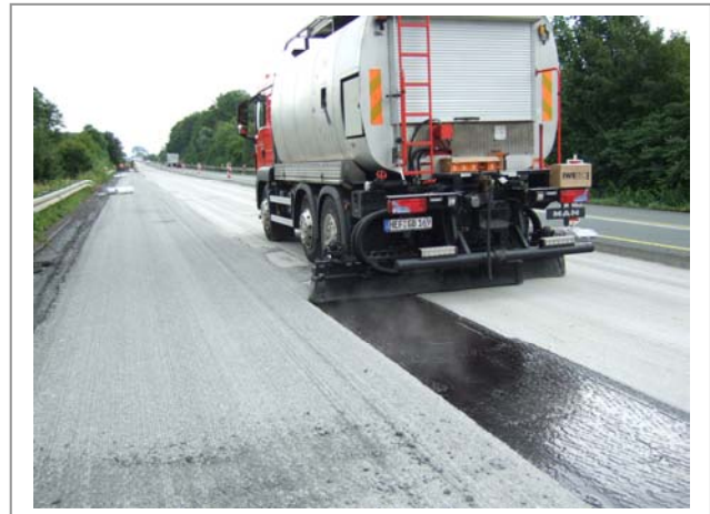
Bild 2: Aufbringen der Bitumenemulsion mit Rampenspritzgerät
