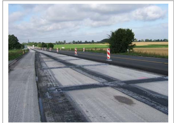
Bild 4: Fertig verlegte Asphalteinlagen - bereit für die Überbauung
