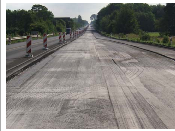
Bild 1: Gefräste und gesäuberte, trockene Fläche vor
