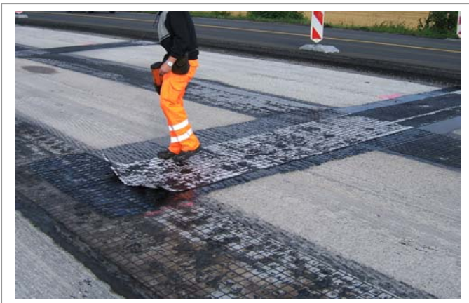
Bild 3: Fixierung der verlegten Asphalteinlagen-Streifen mittig über den Betonplatten
