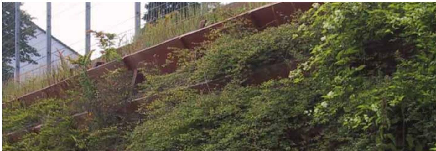
Das System Tensar RC kommt überall dort zum Einsatz, wo hoch schallabsorbierende Stützkonstruktionen gefordert sind. Das System RC besteht aus robusten und langlebigen Recycling-Kunststoffelementen, die mit einaxialen Geogittern stoffschlüssig verbunden sind.
