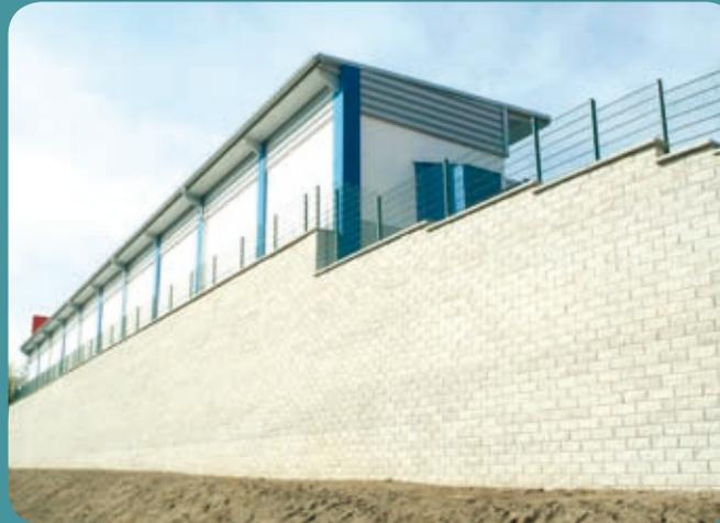
Kostengünstig und ökologisch: Dies zeigte sich bei der Errichtung eines Einkaufsmarktes in Remscheid. Das gebrochene Gestein der ehemals auf dem Gelände vorhandenen Industriebauten wurde ganz im Sinne des Kreislaufwirtschaftsgesetzes als Verfüllmaterial in die bis zu 7 m hohe Konstruktion wieder eingebaut. Auf diesem Wege konnten Massenbewegungen reduziert und ein technisch anspruchsvolles Bauwerk im Sinne unserer Umwelt ökologisch realisiert werden.
