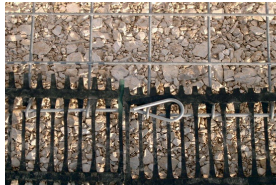
Bild 2: Formschlüssige Verbindung zwischen Geogitter und Stahldrahtgittermatte
