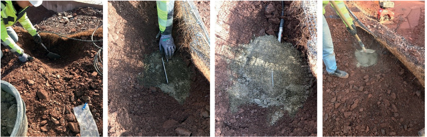
Bild 5: Einbau der Erddruckmessdose Nr. 37 im Frontbereich des Sicherungssystems
