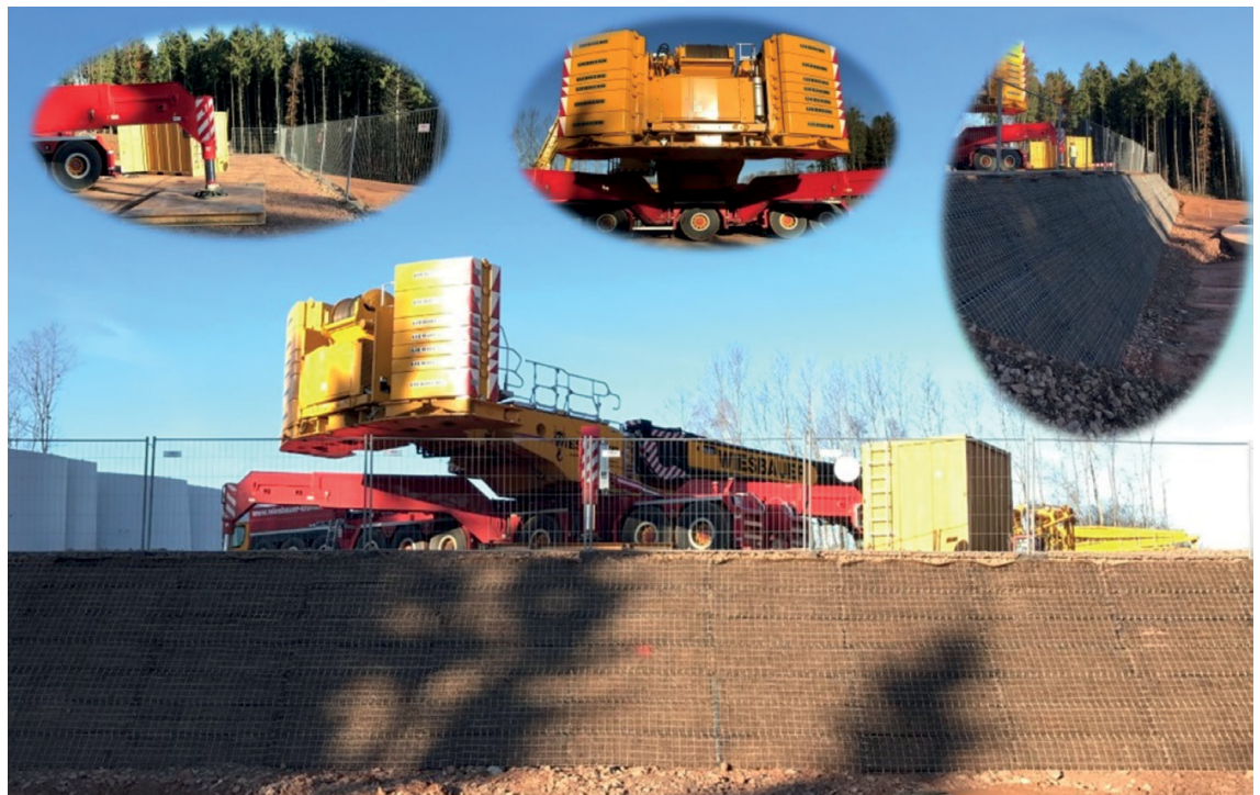
Bild 1: Steilböschungssystem für eine Kranstellfläche zur Errichtung einer Windenergieanlage in Lebach im Saarland
